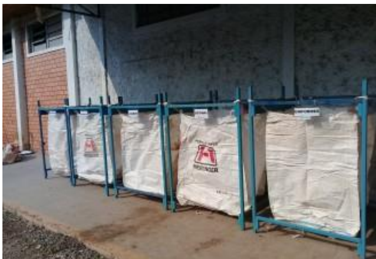
Figura 4 – Contenedores do tipo big bag , com suporte, para acondicionamento de RCC.
